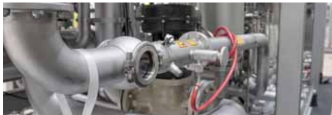
農業機械、鉄道配管、冷却水配管、エア配管、etc...
